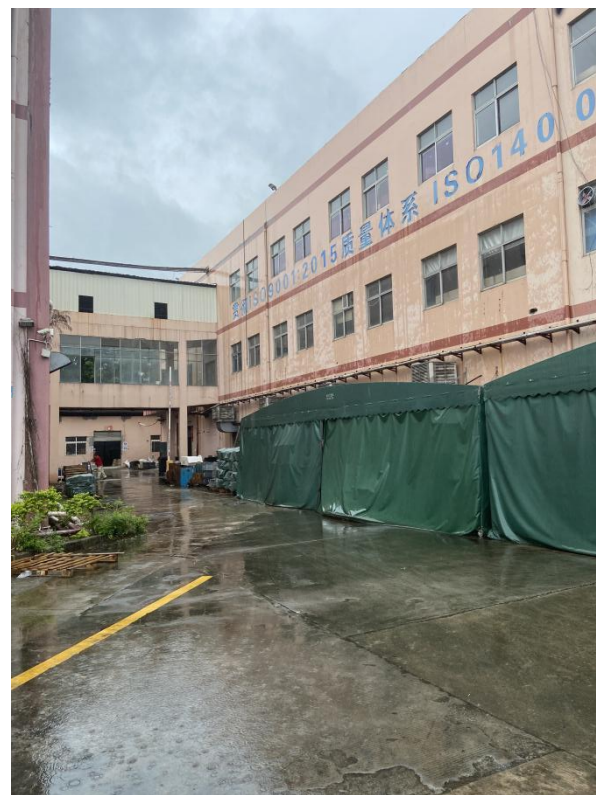
一般固体废物堆放处
