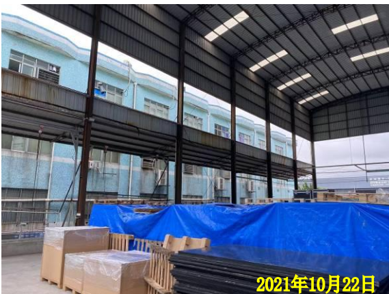
项目北面工业厂房
