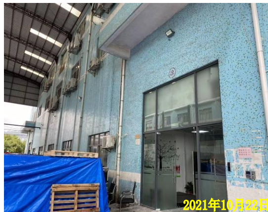
项目厂房现状
