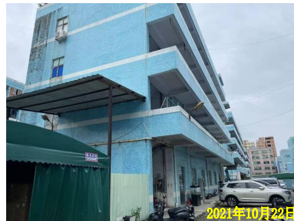
项目西面员工宿舍
