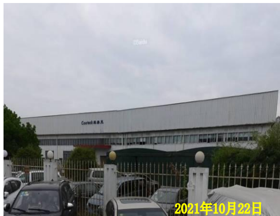
项目东面工业厂房
