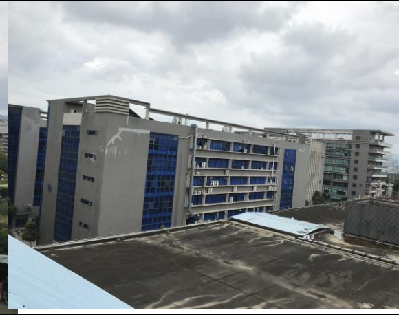
项目南侧厂房
