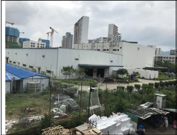
项目东侧厂房
