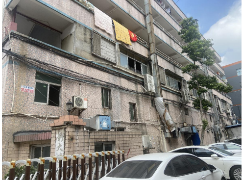
项目西面工业宿舍
