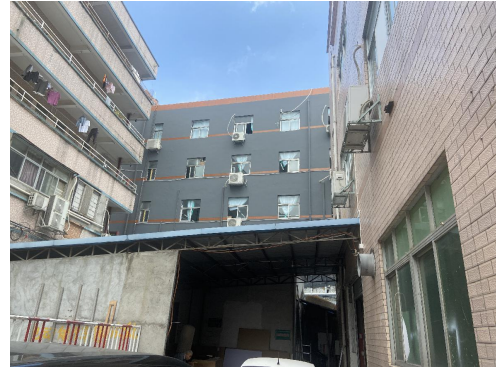
项目北面工业厂房
