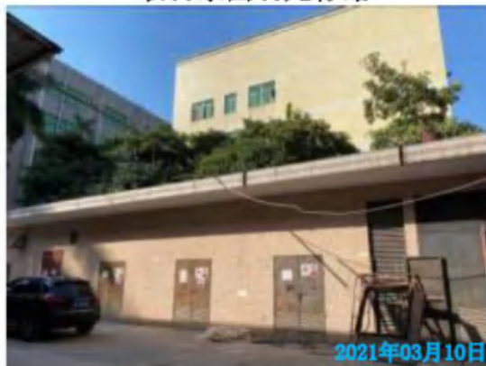
项目北面工业厂房
